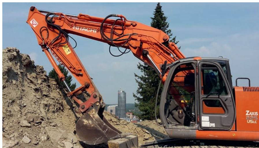
Die Erschließungsarbeiten auf dem Wohnbauareal sind weitestgehend abgeschlossen.
