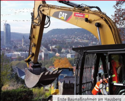
Erste Baumaßnahmen am Hausberg
